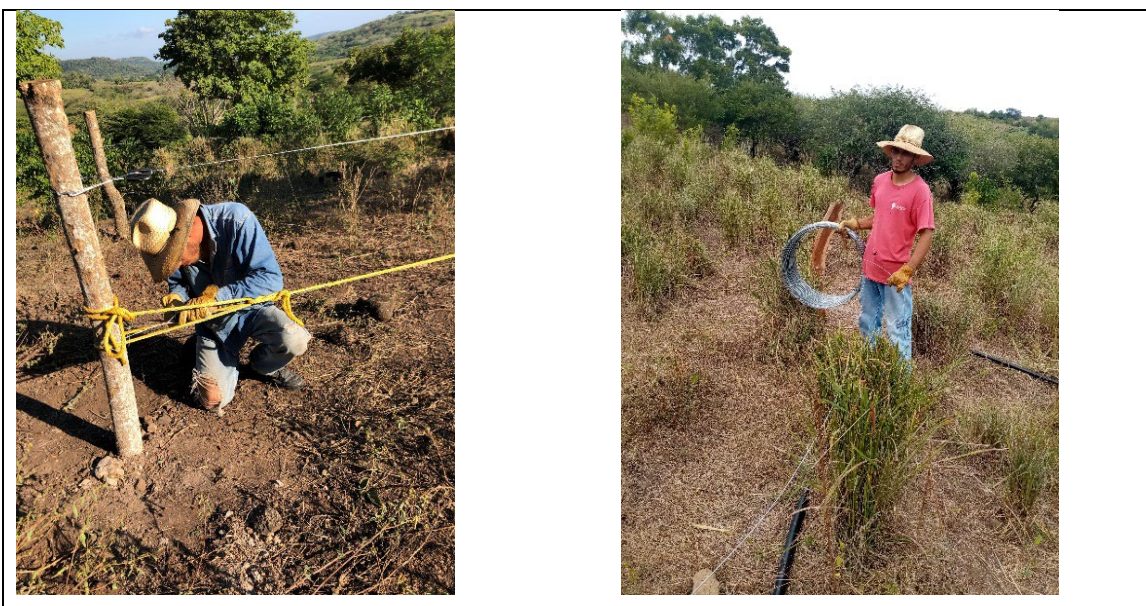
Figura 3. Trabajos de campo: Instalación de cercos eléctricos.
