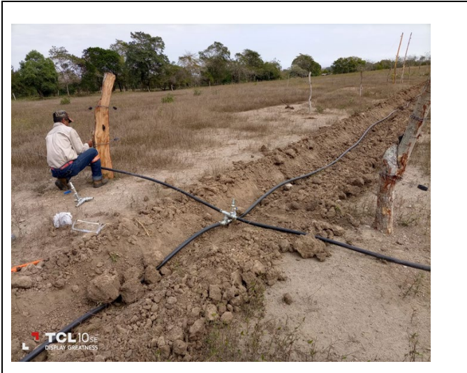
Figura 5. Trabajos para instalar de las redes de abastecimiento de agua.
