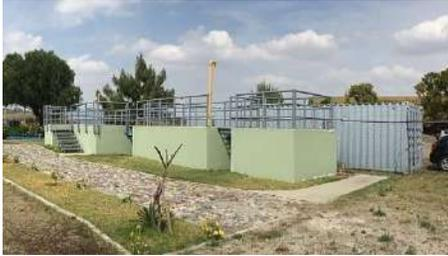
EL SISTEMA ESTÁ DISEÑADO PARA TRATAR AGUAS RESIDUALES DOMÉSTICAS MUY CONTAMINADAS, ALCANZANDO METAS ADICIONALES DE CONSUMO DE ENERGÍA CERO Y ELIMINANDO EL USO DE ADITIVOS QUÍMICOS, SE LOGRA UNA EFICIENCIA DE MÁS DEL 95%.
